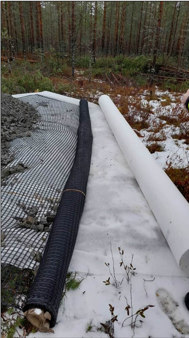
Kuva 14. Turvealueelle tehtävää tierakennetta: alimpana suodatinkangas, jonka päälle tulee lujiteverkko ja kiviaineskerros.
